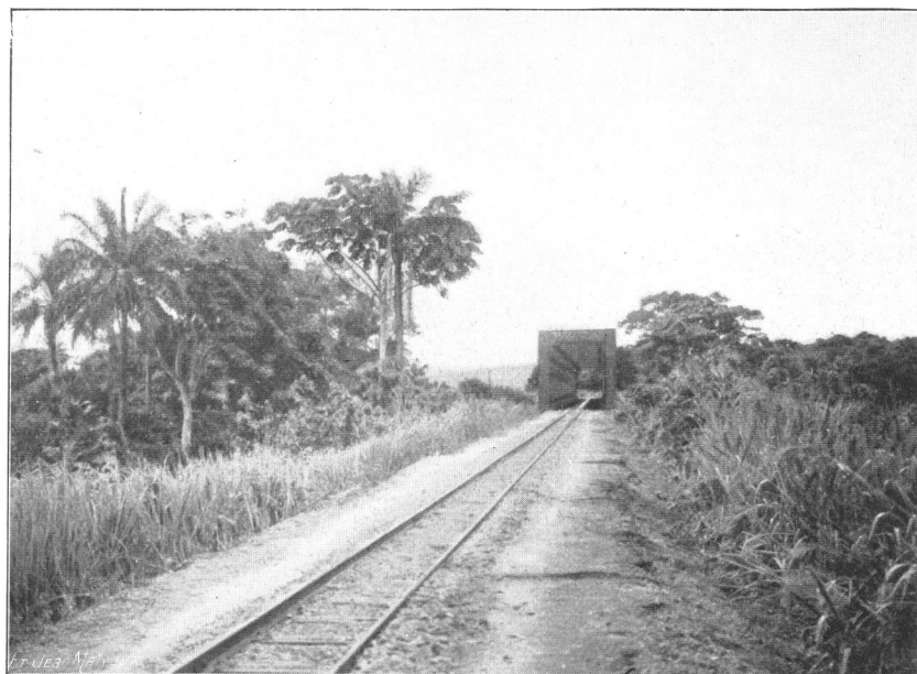
PONT DU KWILU, KILOMÈTRE 146
