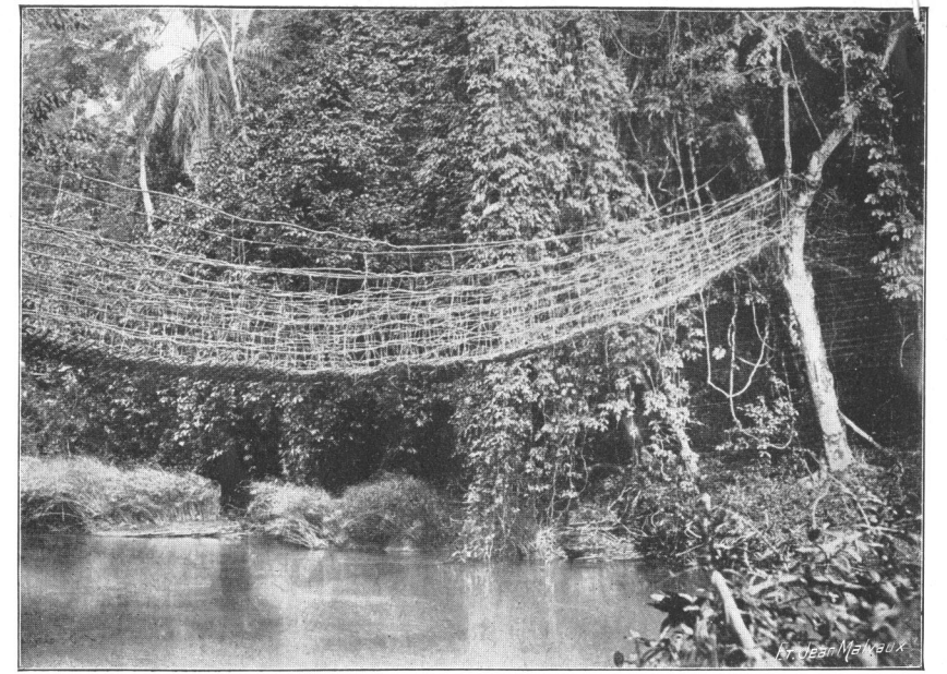
PONT DE LIANES SUR LE KWILU
