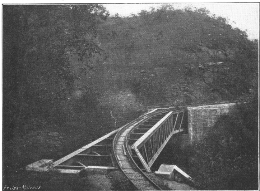
PONT DU RAVIN DE LA CHUTE, KILOMÈTRE 13
