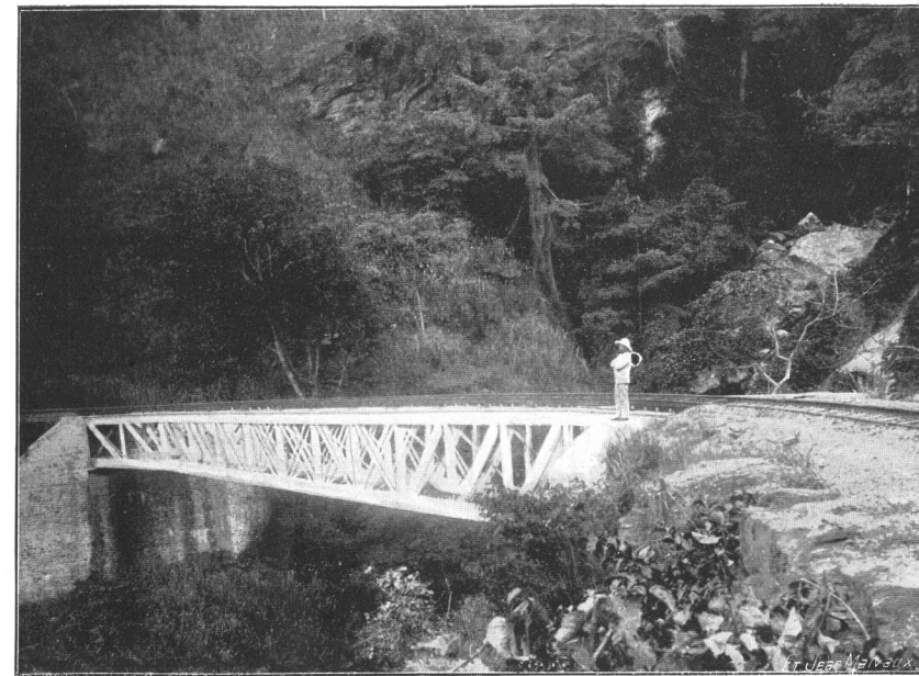
PONT DU RAVIN DU SOMMEIL
