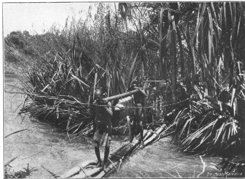
PONT IMPROVISÉ DANS LA RÉGION DU HAUT-KASAÏ
