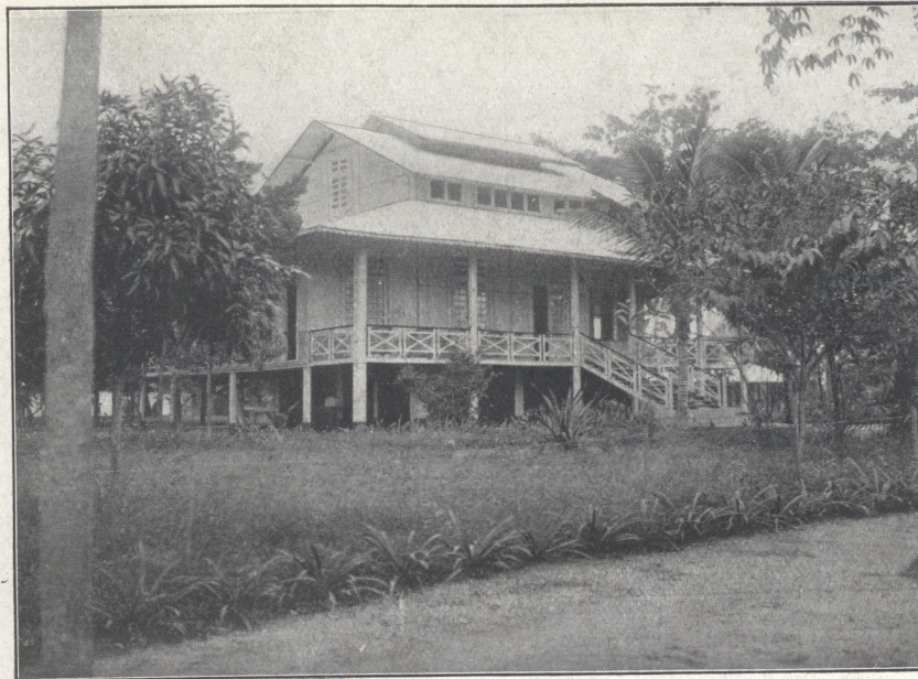
BOMA — HABITATION DES INSPECTEURS D'ÉTAT
